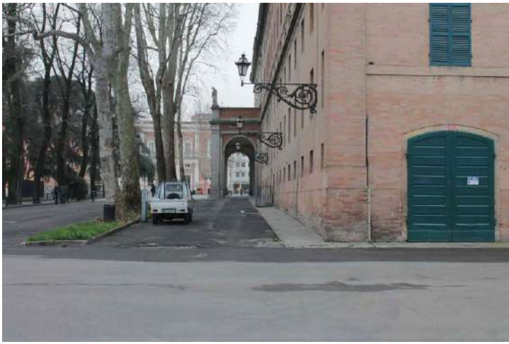
Lato Est Teatro Valli – Area sosta regia esterna
