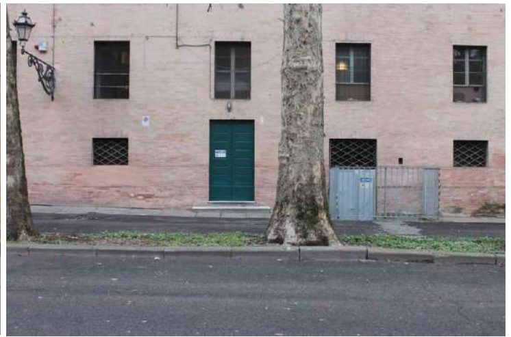
Lato Est Teatro Valli – Accesso uscita emergenza
